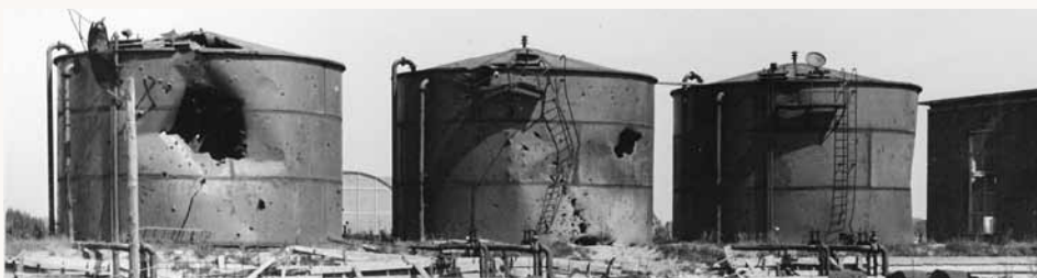
Gaten in de loogtanks op de Kleefse Waard
