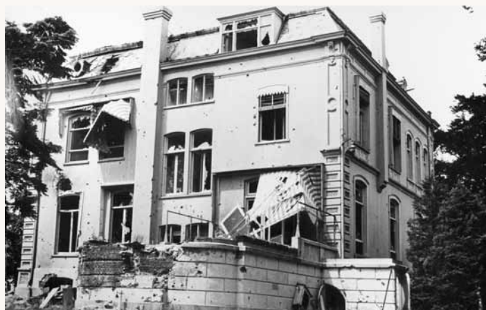
Kantoorvilla Kernheim aan de Velperweg
